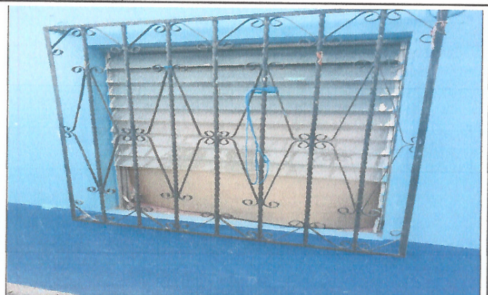
Foto 2: Colocación de nuevos ventanales y ventanas del local que ocupa la Dirección de EODP ANEXA A EOUV.
