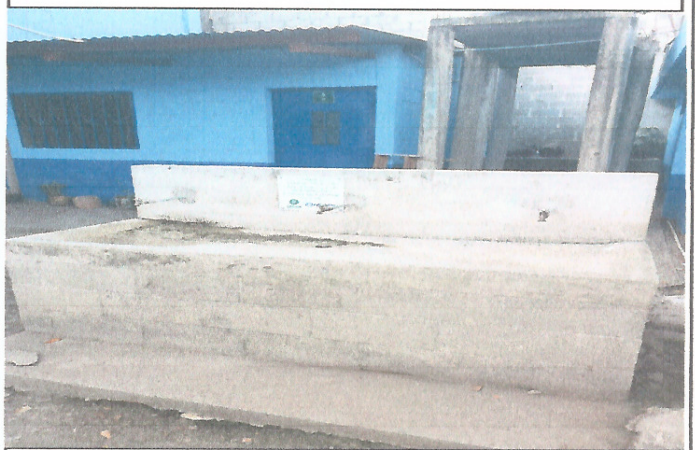
Foto 4: Colocación de Techado en el área para lavamanos de los alumnos en el establecimiento.
