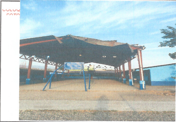
Foto 1: Remozamiento del salón techado del establecimiento que fue dañado por la caída de un árbol.
